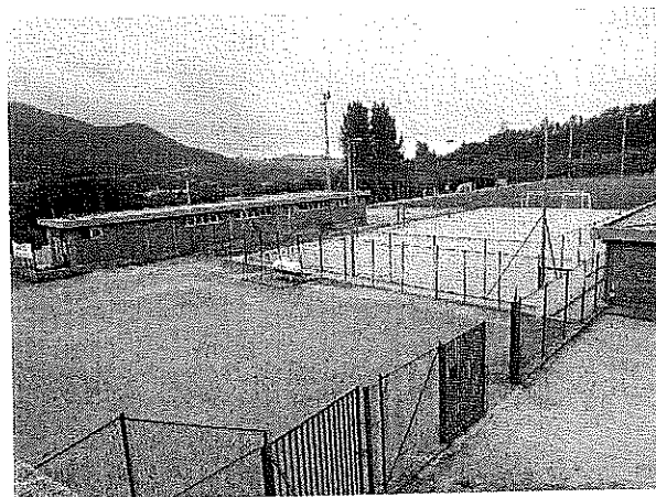
FOTO n. 1 - Campo di calcetto e spogliatoi
