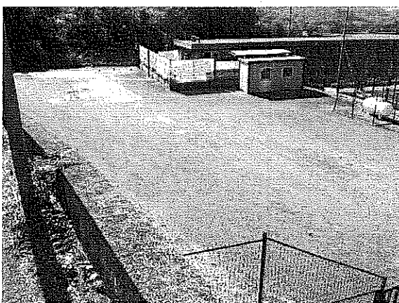
FOTO n. 11 - Stato attuale zona parcheggio
